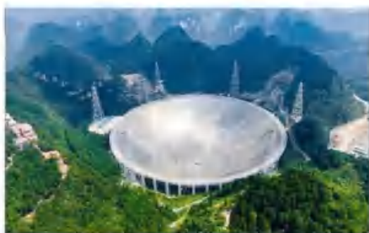
科林电气为世界最大射电望远镜（FAST）提供电力产品
