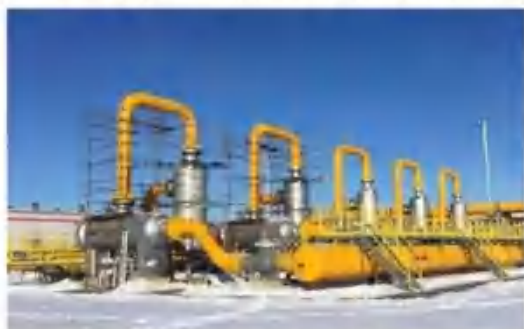
科林电气助力中俄东线天然气管道投产通气
